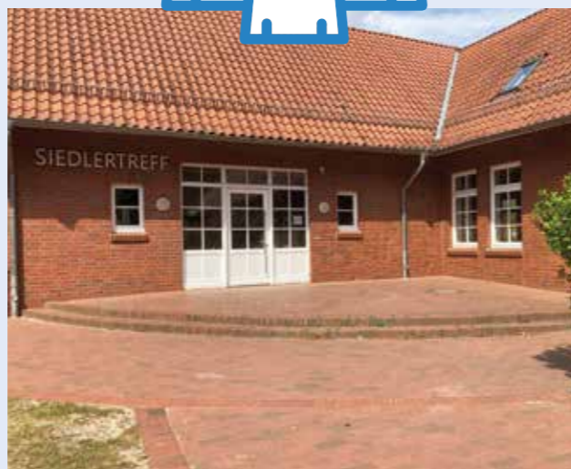
Hier entsteht das neue Vordach als wettergeschützter Aufenthaltsbereich. Foto: © Gemeinnützige Interessengemeinschaft der Siedlung Lappenstuhl e.V.
